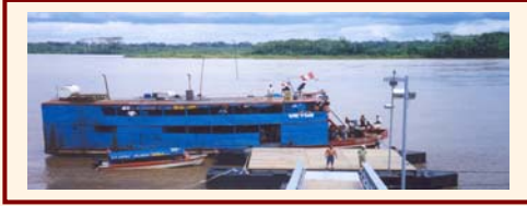
Puesto Fronterizo Cabo Pantoia - Loreto
