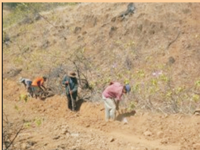
Aporte comunitario. Los pobladores de los cuatro caseríos realizaron la limpieza de zanjas para el tendido de las tuberías, poniendo de manifiesto su interés y compromiso con el proyecto.
