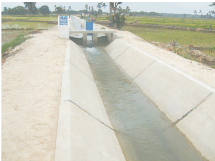
Canal de Bellavista, Sechura. De esta manera lucirán los canales de regadío Álvarez Becara de Vice y El Mango de Rinconada Llicuar, cuando concluyan las obras financiadas por el Fondo Binacional para la Paz y el Desarrollo.
