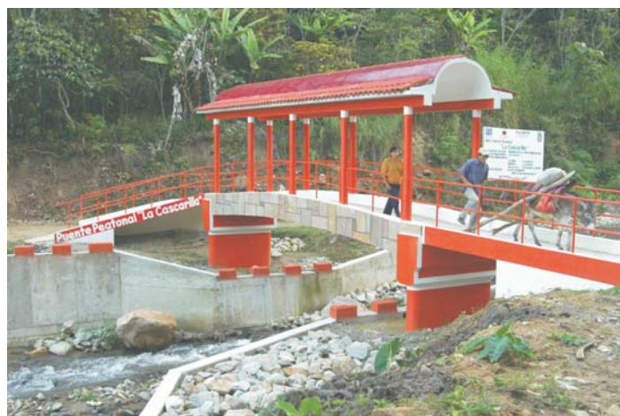
Los pobladores del caserío La Cascarilla, provincia de San Ignacio, ahora pueden transitar sin dificultades durante las épocas de lluvia hacia diferentes caseríos vecinos.
