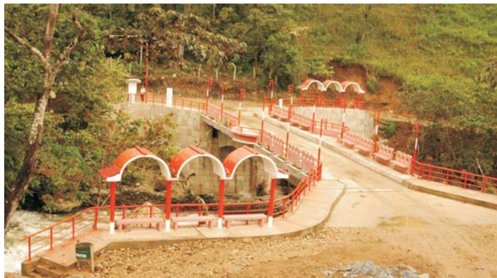
Puente vehicular "El Mirador", ubicado en el distrito de Tabaconas que beneficia a cerca de 2000 pobladores.
