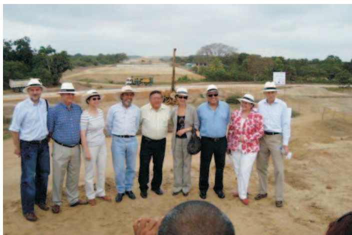
Embajadores de la Comunidad Europea acompañados por el alcalde de Tumbes y el representante de empresa constructora, en el lugar donde se construirá el Puente Internacional del Eje Vial N°1. En la parte posterior, los trabajos de la Variante del lado ecuatoriano.
