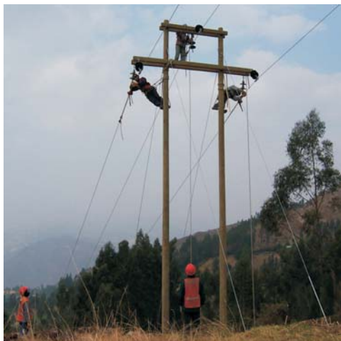
Obra de electrificación
