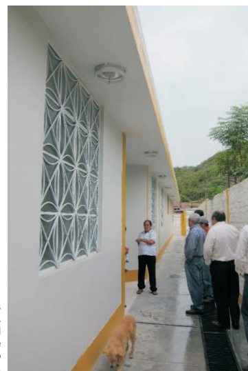
Nuevas instalaciones. Centro de Salud San Pedro de Perico en el distrito de Chirinos, Jaén.
