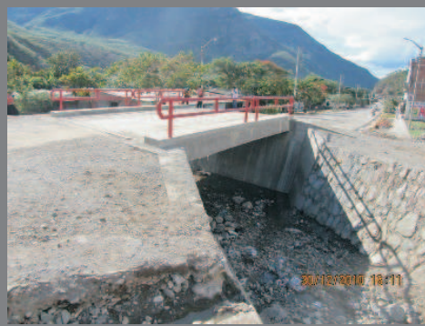
Nuevo puente carrozable "Pucará". Por este puente transitan diariamente cerca de 6,700 pobladores de 21 caseríos y siete sectores del distrito de Pucará.
