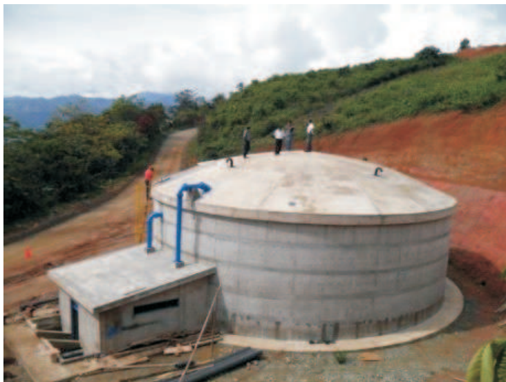
Reservorio listo. Satisfactorio resultado de la prueba técnica efectuada al Reservorio de Agua Potable de la ciudad de San Ignacio.
