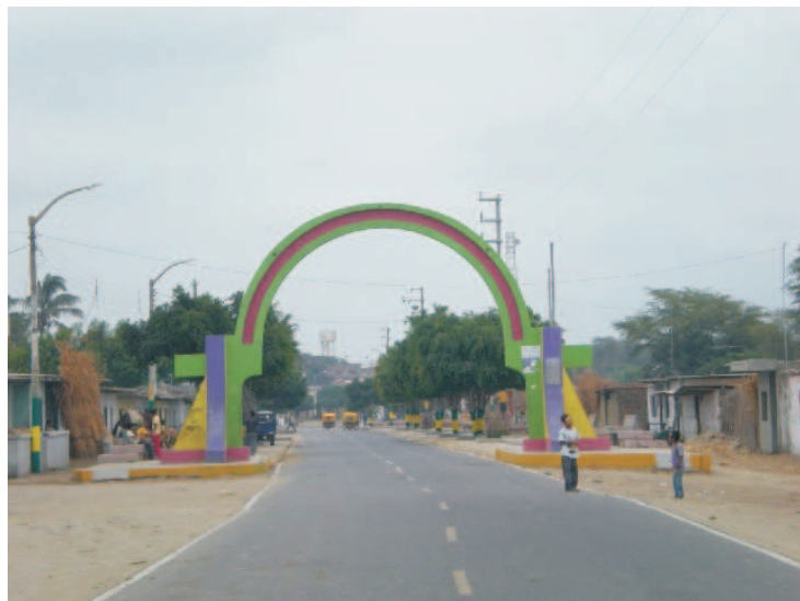
Cucungará. Ya se iniciaron las obras en Cucungará, una de las seis capitales distritales que se beneficiará con el proyecto de agua y saneamiento, además de La Matanza, Bigote, Sicchez, Jilili y Sondorillo, en la Región Piura.
