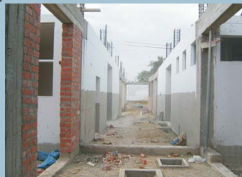
Las autoridades de Salud de la región, dieron a conocer los avances de la construcción del nuevo establecimiento de salud de Aguas Verdes, en la frontera de Tumbes.
