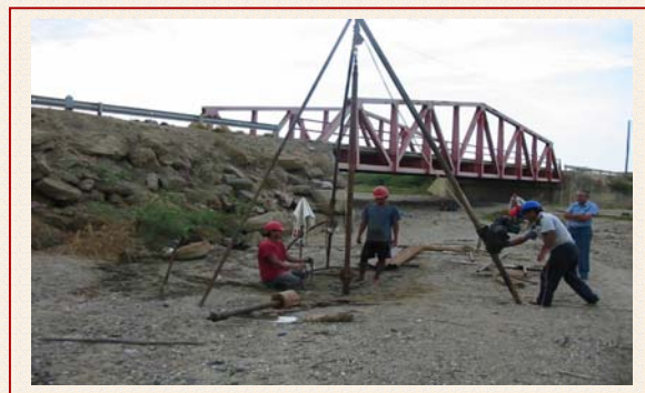
En construcción Puente Plateritos en Tumbes
