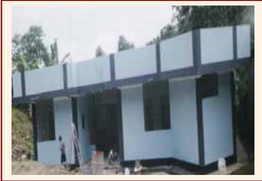
Puesto de salud "Las Naranjas" Jaén - Cajamarca
