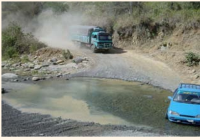
Ubicación del futuro puente internacional en el cruce fronterizo del Eje Vial Nº 2
